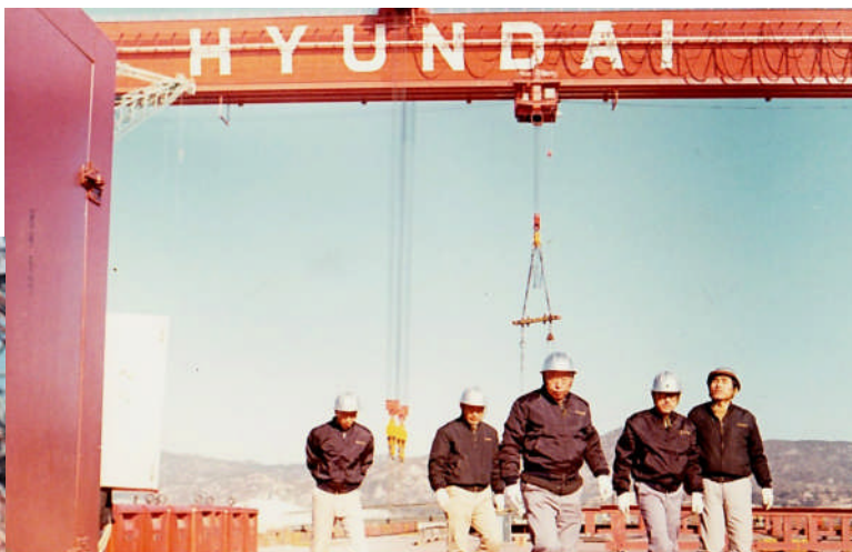
↑ 建設初期、川重造船幹部の蔚山工場建設現場視察
