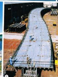
制作中の高速道路構造物
