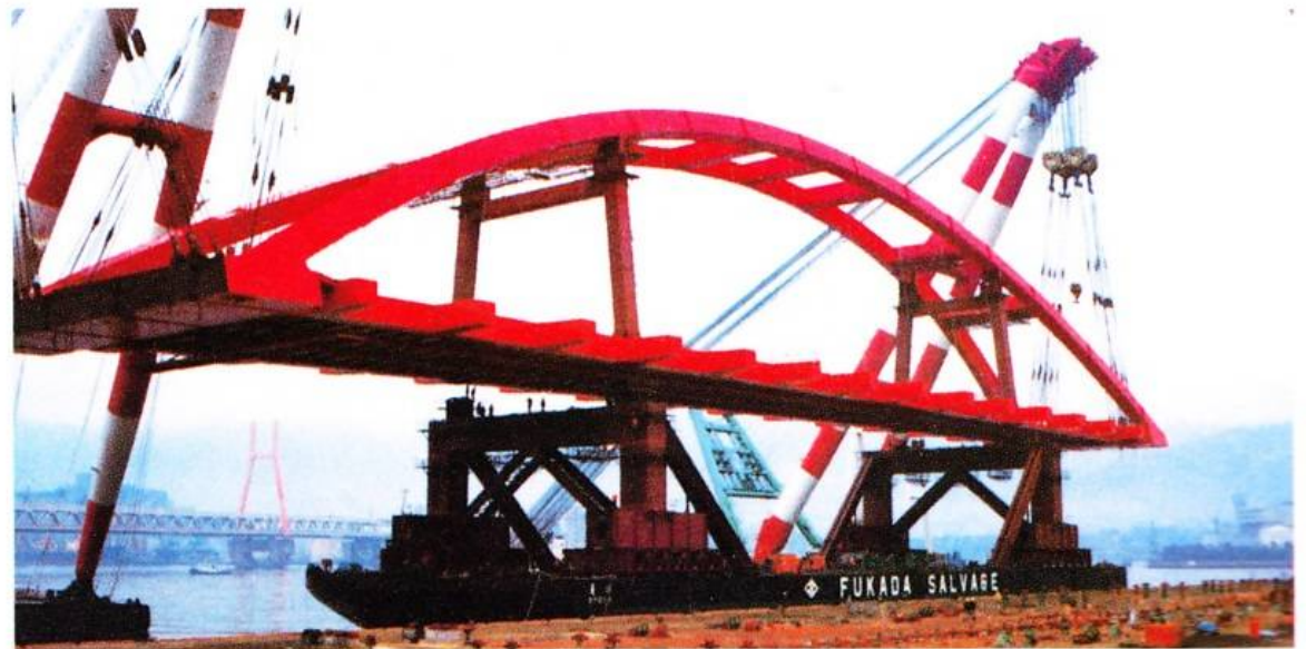
神戸市 灘大橋 フローティングクレーン(2隻)による一括架設
