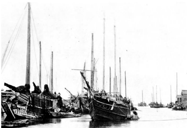
図6 第3世代の合いの子船（中央の船） （図説和船史話より）
