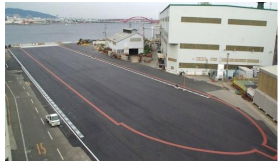
Fig. 11-2 埋戻し後の現状 川重提供
