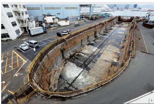
Fig. 1 埋戻し前、可動時の川崎重工・神戸工場第1ドック
