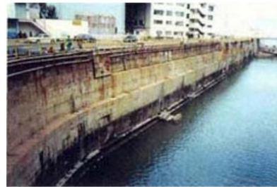
川崎重工業神戸工場第一号ドック
