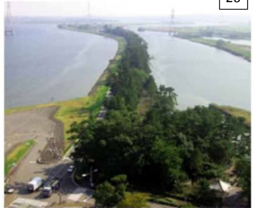
宝暦治水、油島締切堤の跡。旧堤防の跡には、薩摩藩士が植えたという千本松原が並木を作っている。左が長良川、右が揖斐川。 *「水土の礎」より
