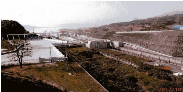
閘門上流部(展望台より)
