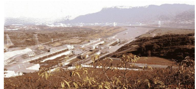
閘門上流部(展望台より)
