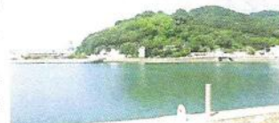
相生湾の東側にあった皆勤橋へ降りる道はコンクリートでかためられていた
