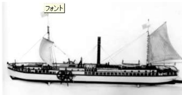
図 2-51 客船クレーモント号 (フルトン:1807) Paddle wheel
