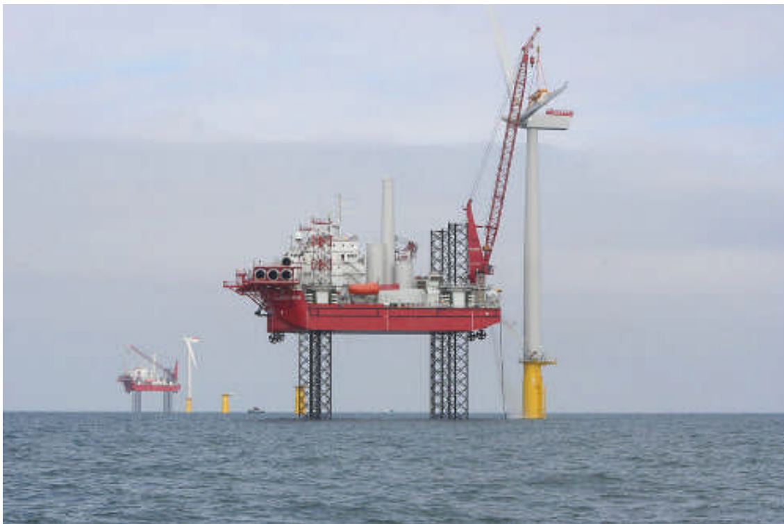
図1 シージャックス社は、欧州における着床式洋上風力設備の建設で豊富な技術を持つ
